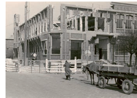
Beschadigd kantoor Den Haag, 1942.
