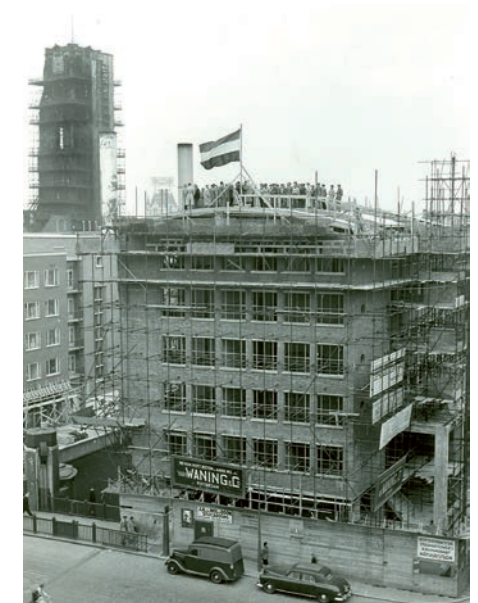
Bouw nieuw kantoor Rotterdam, 1952
