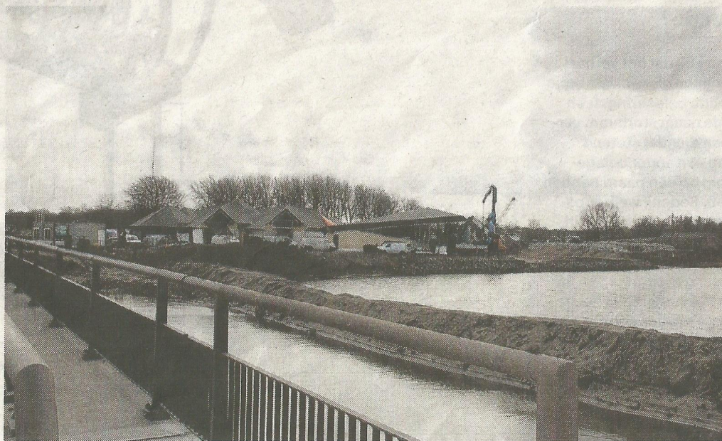
Het bestaande pand uit 1994 moest worden geopend naar het omringende landschap en de zon.
